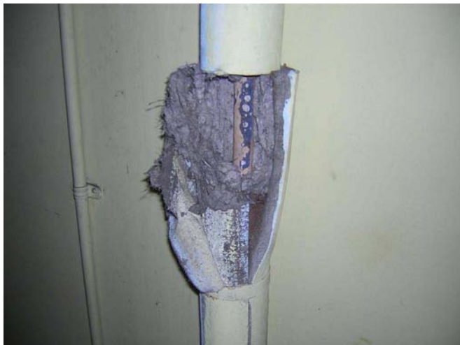
Σχήμα 12.7 Σωλήνας με μόνωση αμιάντου που παρουσιάζει πολλαπλές στρώσεις και διείσδυση του υγρού διαβροχής
