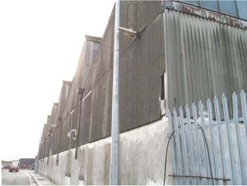
Σχήμα 4.10 Επένδυση με αμιαντοσιμέντο σε εργοστάσιο
