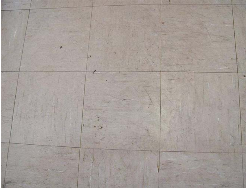
Σχήμα 4.6 Πλακάκια δαπέδου από αμίαντο
