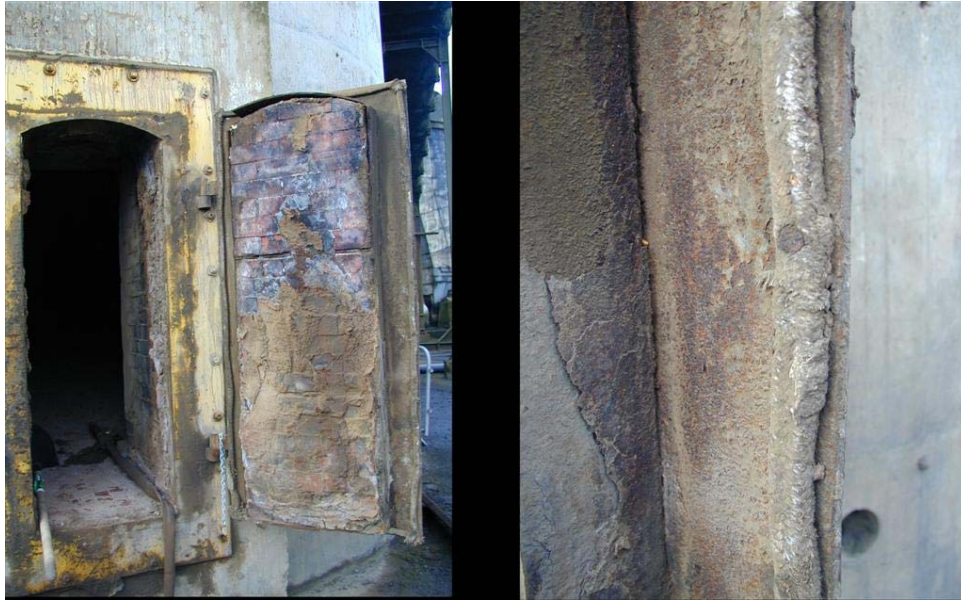
Σχήμα 4.12 Σφράγιση πόρτας καμινάδας με αμιαντόσχοινο. Η εικόνα στα δεξιά είναι κοντινή όψη του σχοινοῦ.
