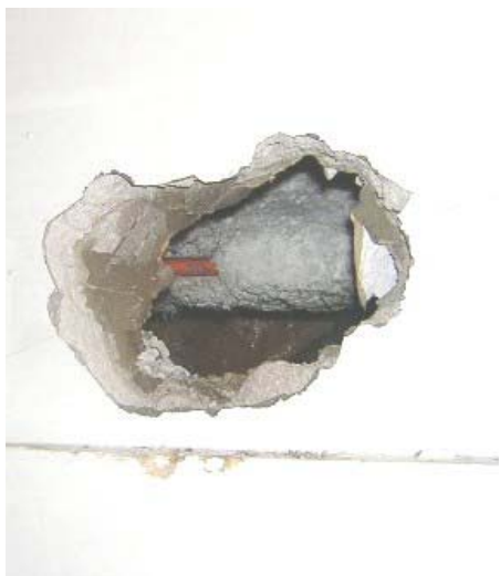
Σχήμα 4.4. Τρύπα σε τοίχο για να αποκαλυφθεί η μόνωση του αμιαντοσωλήνα.
