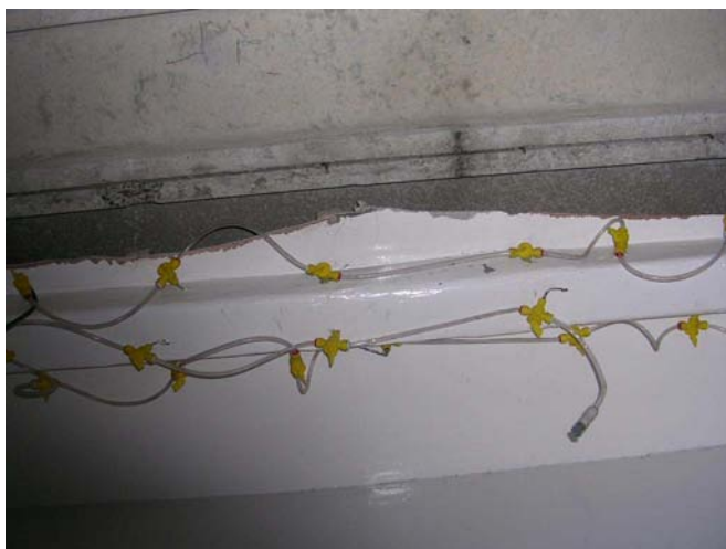
Σχήμα 12.10 Παράδειγμα έκχυσης πολλαπλών σημείων που χρησιμοποιείται για την ύγρανση ψεκασμένου αμιάντου μόνωσης.
