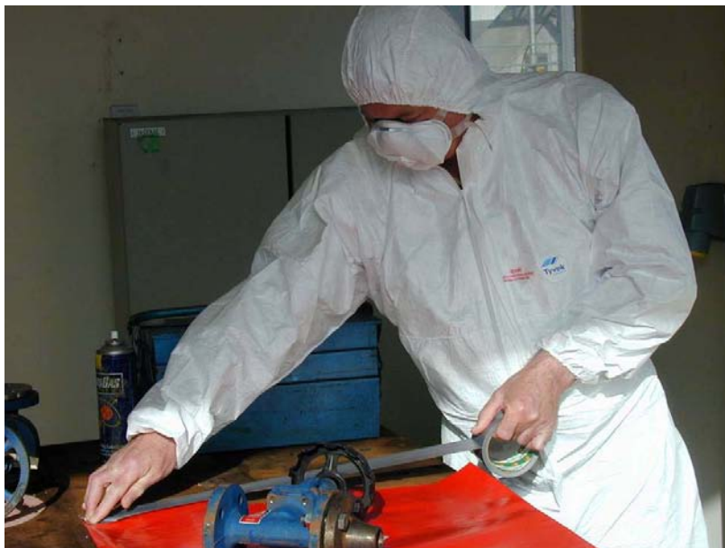
Σχήμα 11.3 Χρήση κολλητικής ταινίας και φύλλου πολυαιθυλενίου για την προστασία της περιοχής εργασίας πριν τον καθαρισμό τσιμούχας αμιάντου από μια βαλβίδα
