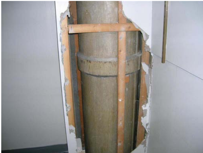
Σχήμα 4.2 Το περίβλημα από μονωτική αμιαντόπλακα αφαιρέθηκε εν μέρει για να αποκαλυφθεί ο καπναγωγός από αμιαντοσιμέντο.
