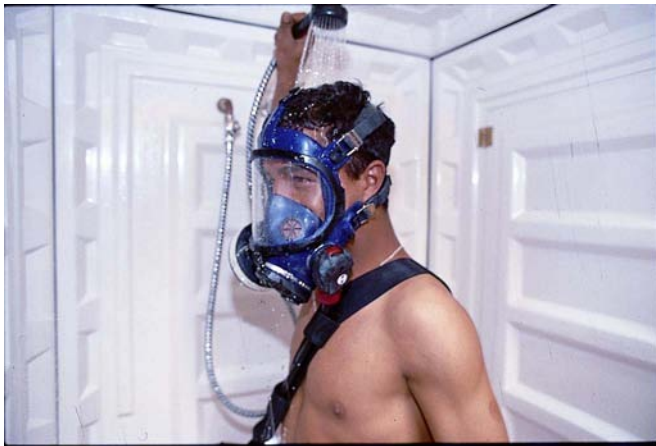
Σχήμα 12.5 Απορρύπανση με ηλεκτρική σκούπα τύπου Η, μέσα στη ντουζιέρα με αδιάβροχη ολόσωμη φόρμα, και μετά ντους πριν από την αφαίρεση του αναπνευστικού εξοπλισμού προστασίας (οι φωτογραφίες είναι προσφορά του INRS και πνευματική ιδιοκτησία του INRS).
