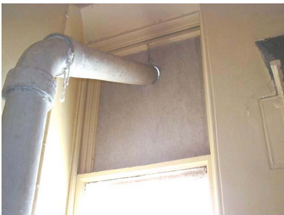
Σχήμα 4.5 Καπναγωγός από αμιαντοσιμέντο με σφραγίσματα από αμιαντόσχοινο ο οποίος περνά μέσα από πάνελ το οποίο κλείνει ένα άνοιγμα.
