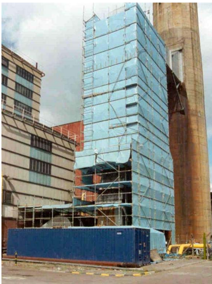
Σχήμα 12.3 Περίβλημα για την αφαίρεση μονωτικής επένδυσης από βιομηχανική καμινάδα
