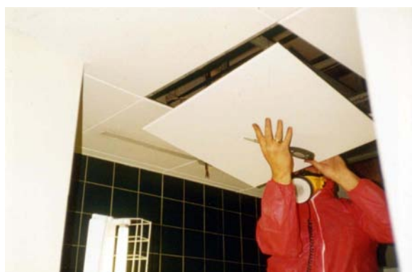
Σχήμα 12.13 Προσεκτική αφαίρεση πλακιδίου από αμίαντο
