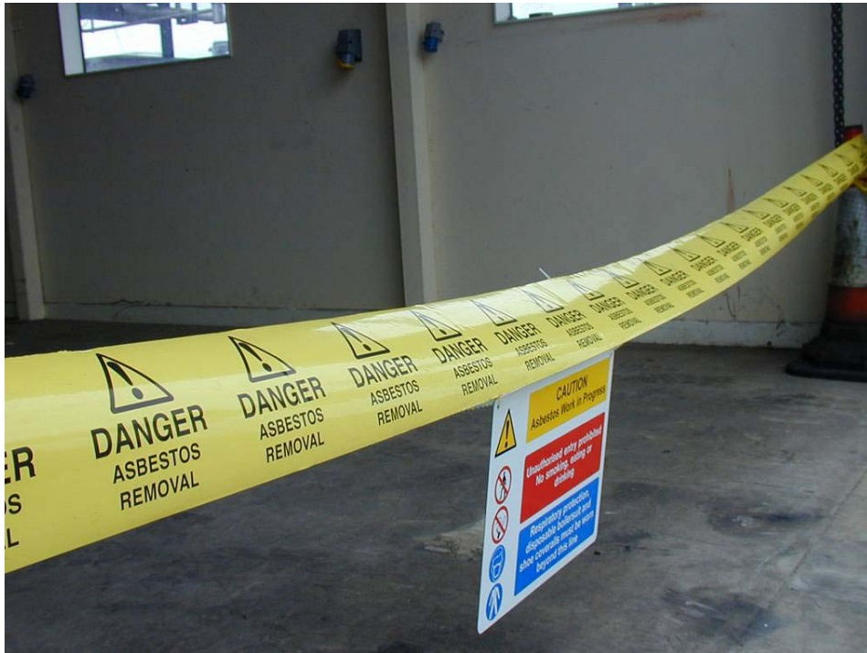
Σχήμα 11.1 Χρήση προειδοποιητικής ταινίας και πινακίδων για τον αποκλεισμό μιας περιοχής
