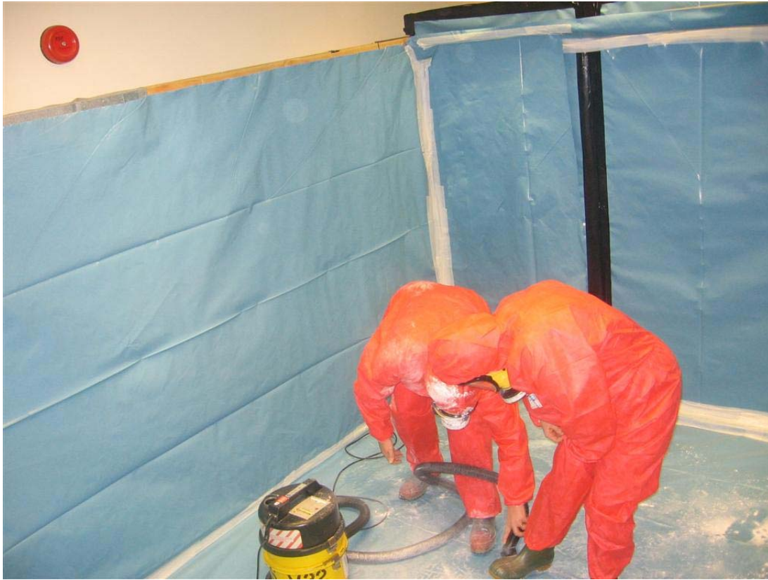
Σχήμα 7.1 Πρακτική εξάσκηση στη χρήση ηλεκτρικής σκούπας τύπου Η για την αφαίρεση προσομοιωμένης ρύπανσης (σκόνη ταλκ). Η φωτογραφία προσφέρθηκε από την Υπηρεσία Υγιεινής και Ασφάλειας του Ηνωμένου Βασιλείου.
